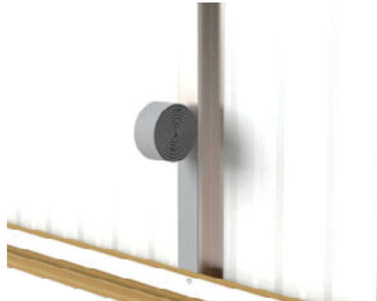
APLICAÇÃO DA FITA ACÚSTICA NA ESTRUTURA
